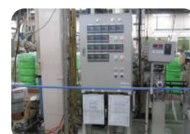
加高控制装置的设置场所，防止漏电
